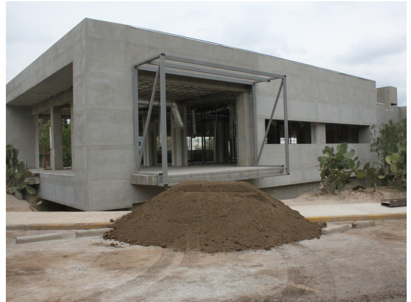
Obra negra del edificio H del CIO.
