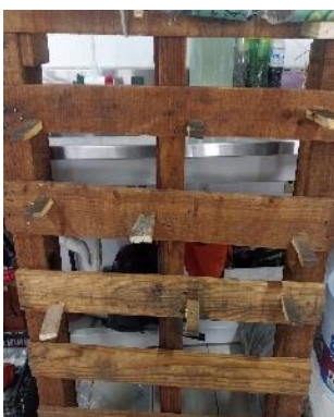
Figura 6. Instalar soportes en la estructura.
